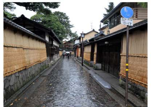
長町武家屋敷群／土壁も雪から守るため、コモが架けてあります。
